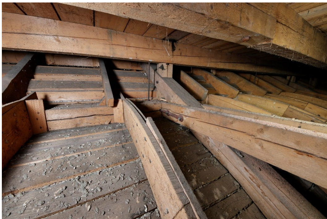
27. Celkový pohled na podlahové trámy se záklopem a konstrukci stropního podhledu nad hlavním sálem.
