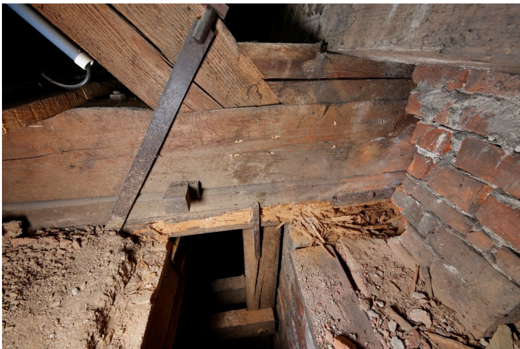
22. Detailní pohled na zhlaví č. 48 (vyznačeno na výkrese Půdorys krovu) u plné vazby krovu, silně poškozené celulósovorní houbou a červotočem.
