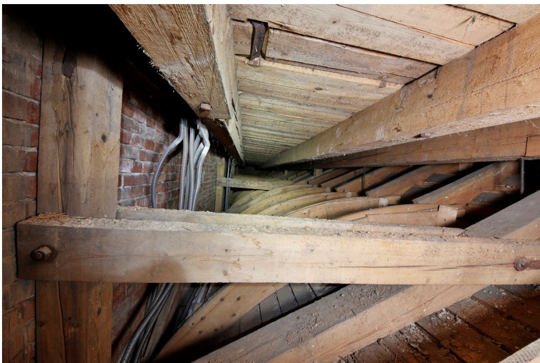
26. Celkový pohled na podlahové trámy se záklopem a konstrukci stropního podhledu nad hlavním sálem.
