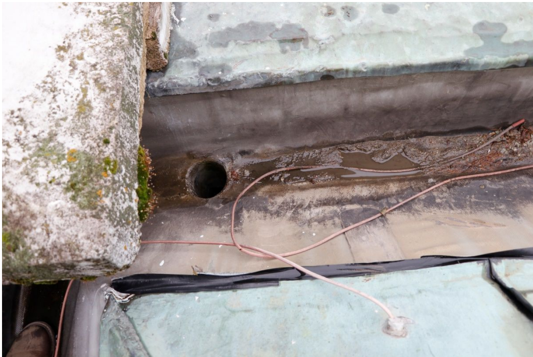
13. Detailní pohled na stávající odvodnění zaatikového žlabu na střeše nad hlavním sálem a topný kabel umístěný do žlabu během poslední opravy.
