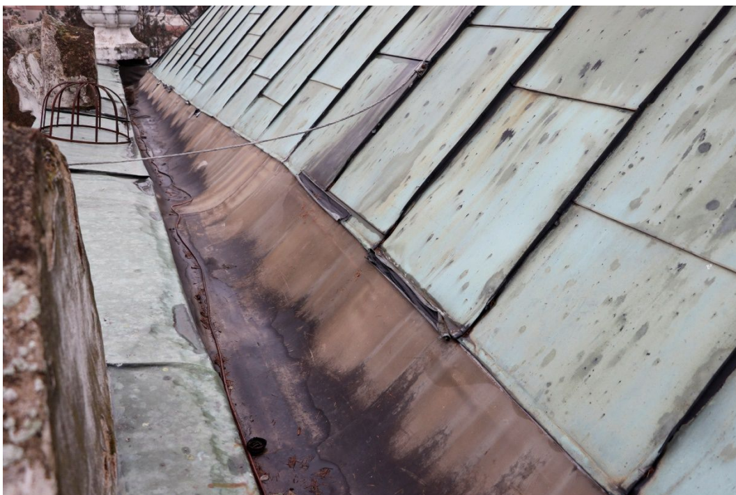
12. Detailní pohled na stávající řešení odvodnění zaatíkového žlabu pomocí dodatečně vložené fólie PVC upevněné do drážky střešní krytiny z měděného tabulového plechu.
