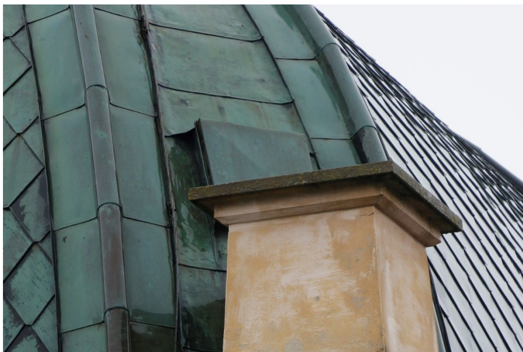
36. Detailní pohled na oplechování nároží na střeše nad jevištěm – vzor pro oplechování nároží na střeše nad hlavním sálem (hledištěm).
