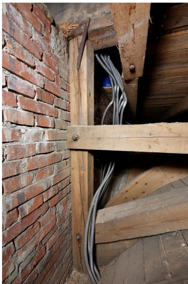
27. Celkový pohled na podlahové trámy se záklopem a konstrukci stropního podhledu nad hlavním sálem.
