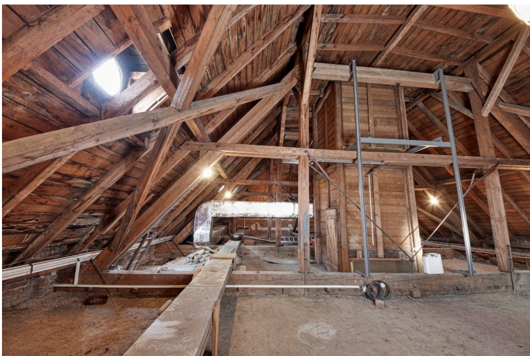
30. Celkový pohled do krovu nad hlavním sálem od jihu, uprostřed vestavba s pomocným odvětráním hlavního sálu, do které nebude zasahováno.
