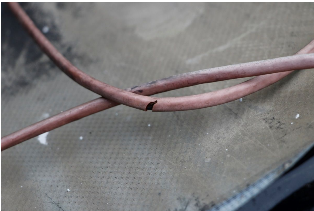
14. Detailní pohled na poškození stávajícího topného kabelu v zaatikovém žlabu u střechy nad hlavním sálem.
