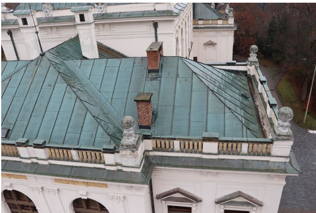
16. Celkový pohled z vysokozdvížené mobilní plošiny na střechu nad JV křídlem budovy – centrální a východní část – s obvodovou zdí hlavního sálu, do které budou kotveny konzoly pro založení části lešení.
