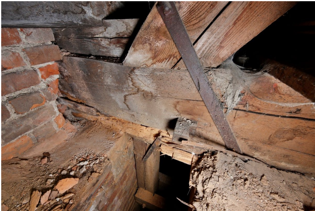
21. Detailní pohled na zhlaví č. 44 (vyznačeno na výkrese Půdorys krovu) u plné vazby krovu, silně poškozené celulósovorní houbou a červotočem.
