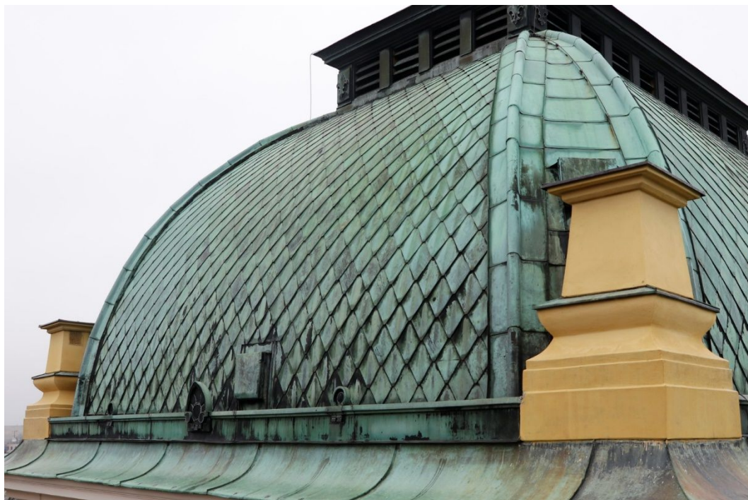
35. Celkový pohled na oplechování nároží na střeše nad jevištěm – vzor pro oplechování nároží na střeše nad hlavním sálem (hledištěm).
