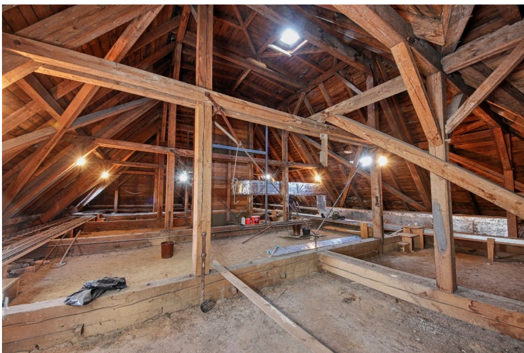
18. Celkový pohled do krovu nad hlavním sálem na plnou vazbu, provedenou jako dvojitě te-sařské věšadlo s třetím věšákem z ocelových táhel uprostřed rozpětí vazného trámu.
