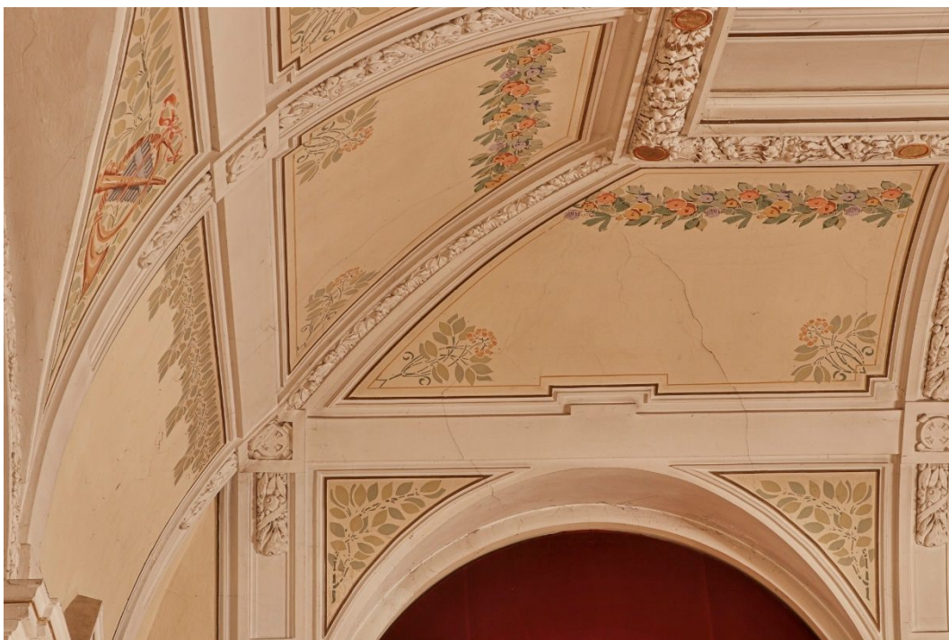
34. Detailní pohled na trhliny v omítkách na podhledu u východního nároží hlavního sálu.
