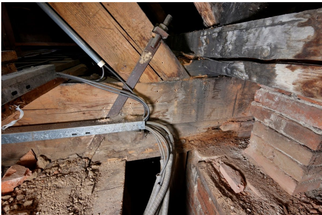
25. Detailní pohled na zhlaví č. 56 (vyznačeno na výkrese Půdorys krovu) u plné vazby krovu velmi silně poškozené celulózovorní houbou a červotočem. Spodní část zhlaví je vlivem destrukce dřevní hmoty zabořená do podkladního kvádru do hloubky cca 5 cm. Stav této vazby je možné pokládat za havarijní.
