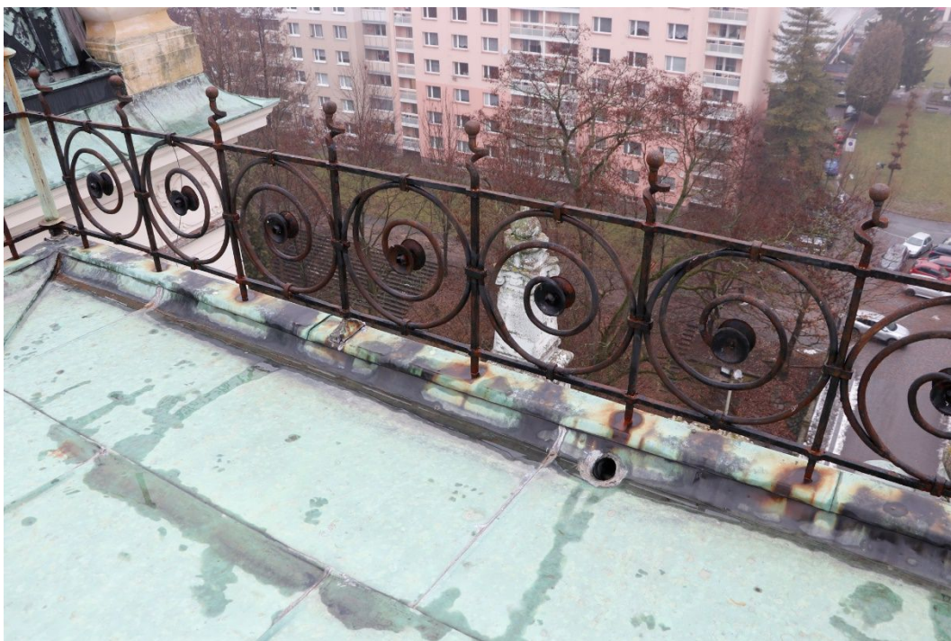
10. Detailní pohled na stávající problematické odvodnění horní části střechy nad hlavním sálem, zajištěné pomocí mělkého žlabu a malého otvoru skrz zvýšený okraj střechy.
