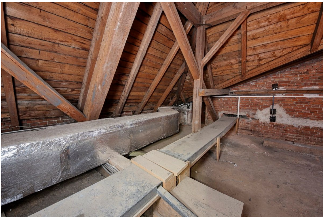
17. Pohled na západní větev kabelové trasy pro osvětlení a ozvučení jeviště a na doplňkové odvětrání hlavního sálu vyústěné do západního nároží na půdě nad hlavním sálem.
